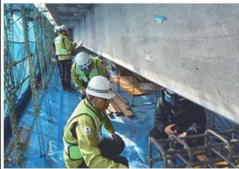
工事完了までの無事故無災害を呼び掛けた ＝薩摩川内市の現地
