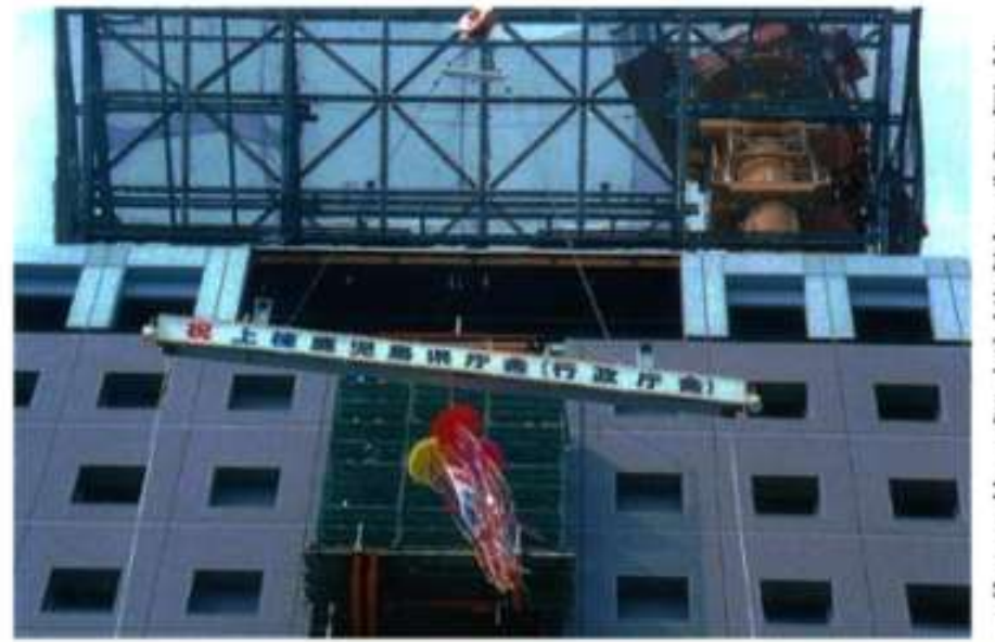
行政庁舎上棟式(平成 7 年 10 月)
